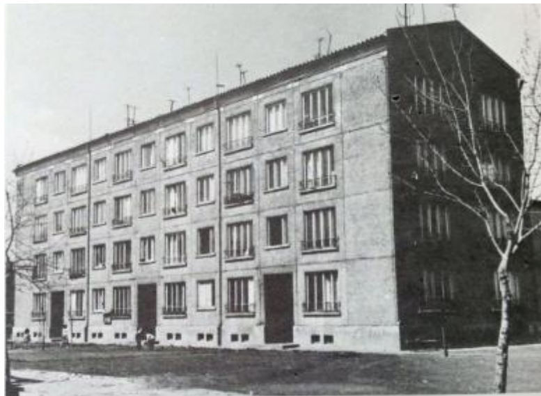
Първата опитна панелна жилищна сграда в „Красна поляна“ в София, колектив от НИСИ с ръководител инж. Г. Бранков, 1958 г. 313
