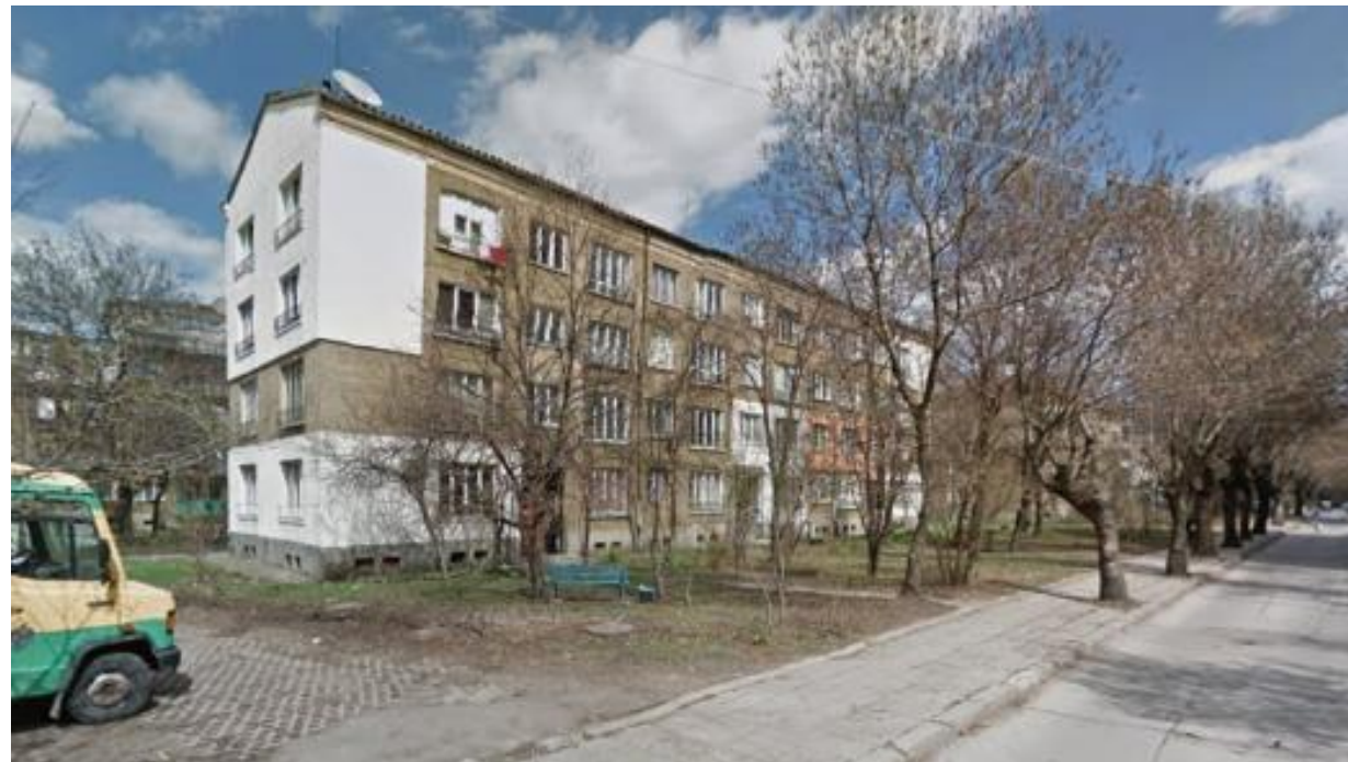
Първата опитна панелна жилищна сграда в „Красна поляна“ в София, колектив от НИСИ с ръководител инж. Г. Бранков, 1958 г. 313
